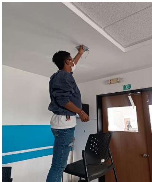
Figura 1. Paso de Cable en las Instalaciones
